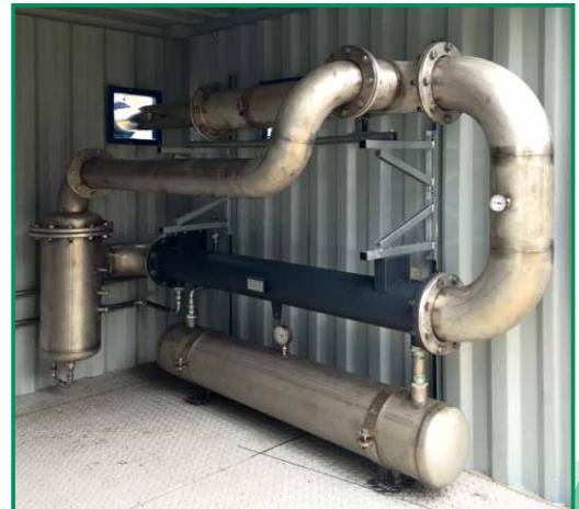
Gaskühlung mit Querstromwärmetauscher
